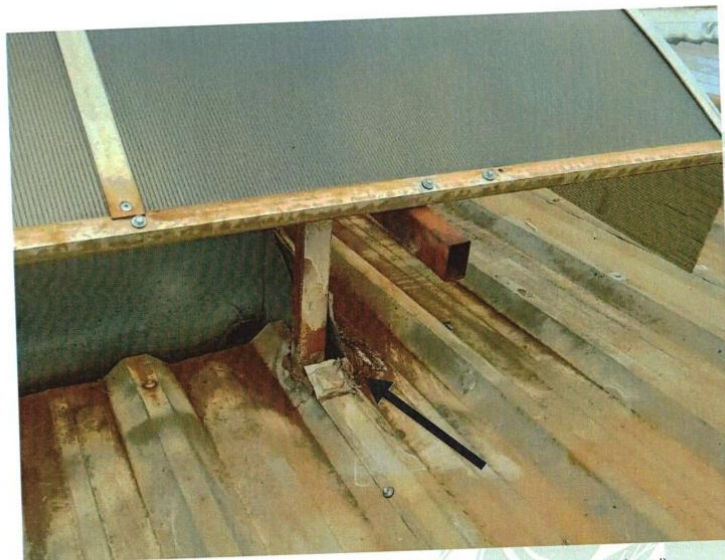
Figura 20 – Abertura no final da calha (Fonte: Luís Gustavo, no local)
