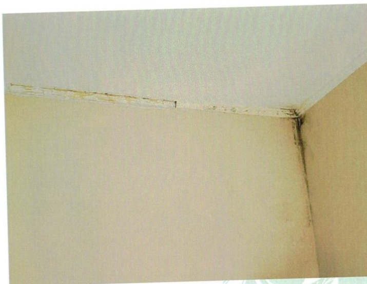
Figura 8 – Umidade e sujeira na Sala 02 (Fonte: própria, no local)
