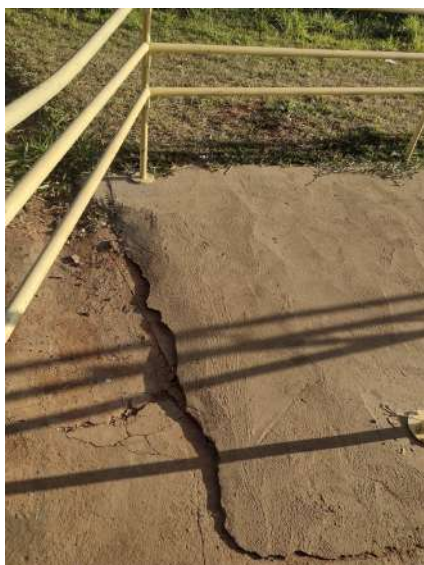
Rampa de acesso à quadra com falha de nivelamento de piso
