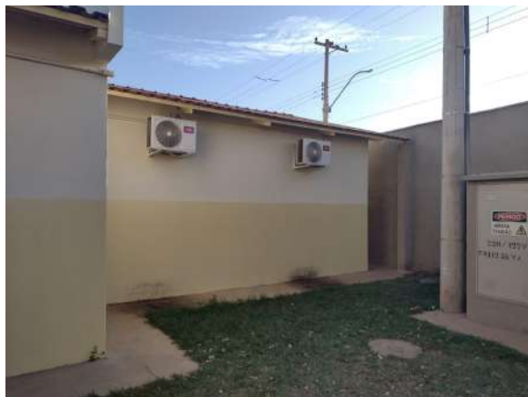
Parede com umidade abaixo das condensadoras
